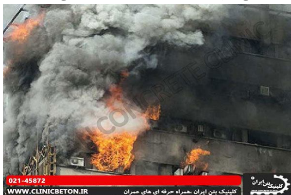
ساختمانی بتنی در آتش
