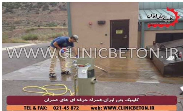
ترمیم بتن به روش ملات سیمانی
