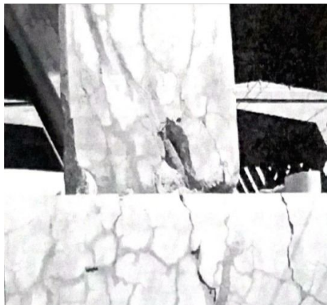
شکل ۸-۱۵- تخریب بتن به دلیل حمله یون های سولفات
